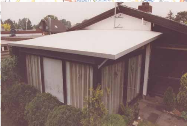
Überdachung eines Wintergartens
